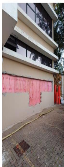
abertura de vão para nova recepção
