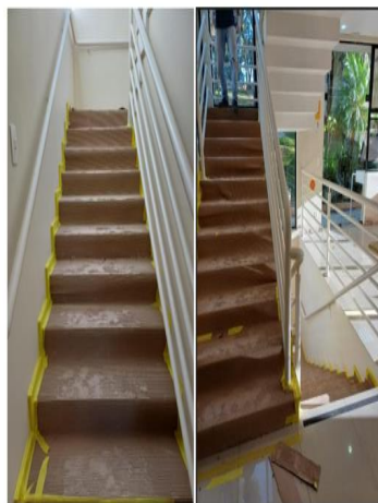
Proteção das escadas
