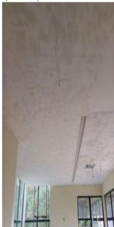
Cimento forro área gourmet
