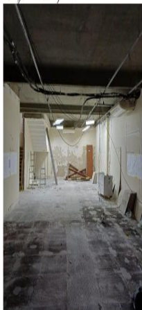
demolição do primeiro pavimento: gesso, drywall e porcelanato
