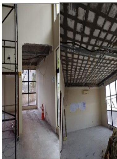
demolição do segundo pavimento: gesso, drywall e porcelanato
