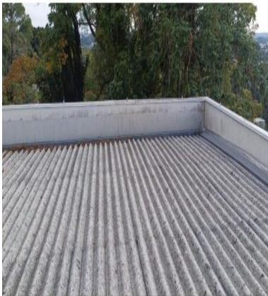
âncoragem na cobertura
