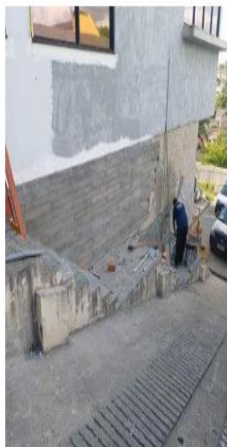
Vista lateral fachada externa com ripado concreto.
