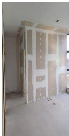
Drywall sala servidor
