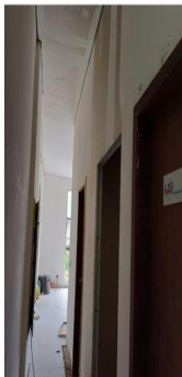
Preparação de parede para receber cimento queimado
