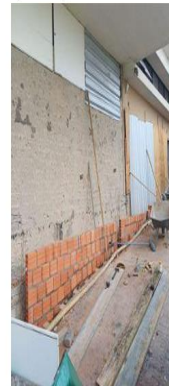
Fachada: Fôrma em alvenaria
