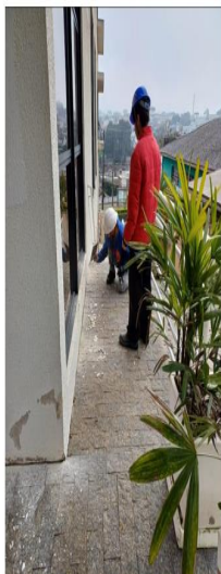
Tratamento de infiltrações
