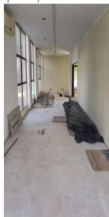
Piso 2: piso e forro.
