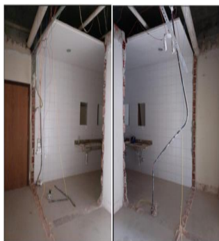
demolição parcial do banheiro feminino e masculino do 1 pavimento
