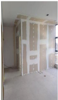
Drywall sala servidor
