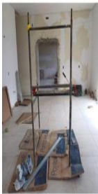
Instalação de novo fôrmo com nova iluminação
