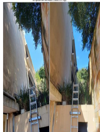
Limpeza da fachada
