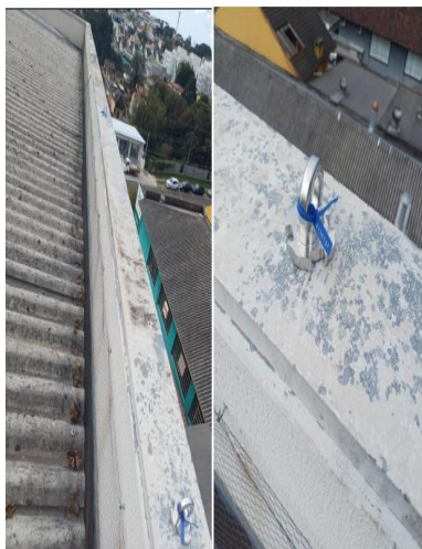
Ancoragem na cobertura
