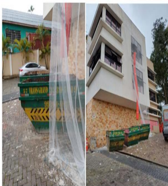
caçambas de calça e tela fachada
