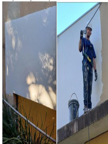
Teste com massa niveladora
