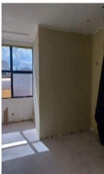
Sala apoio auditório concluída.
