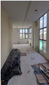
Piso 2: piso e forro.
