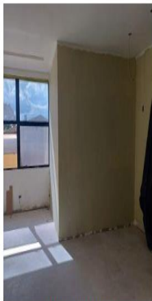
Sala apoio auditório concluída.
