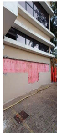
abertura de vão para nova recepção
