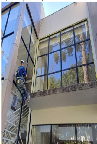
Limpeza da fachada
