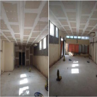
Recepção: Piso, forro e ripado concreto concluídos.
