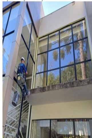
Limpeza da fachada
