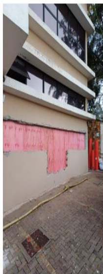
abertura de vão para nova recepção
