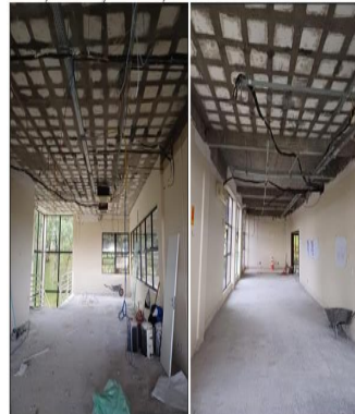
demolição do terceiro pavimento: gesso, drywall e porcelanato
