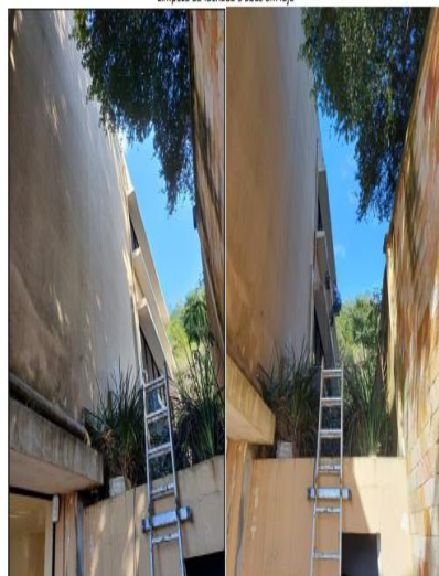
Limpeza da fachada
