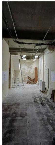
demolição do primeiro pavimento: gesso, drywall e porcelanato
