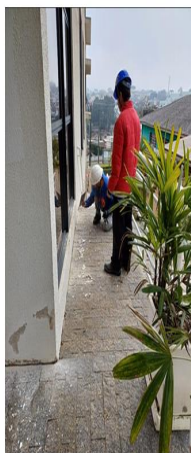
Tratamento de infiltrações
