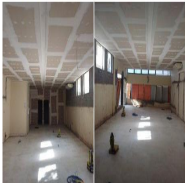
Recepção: Piso, forro e ripado concreto concluídos.
