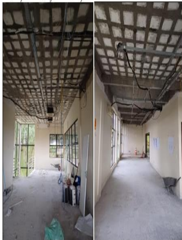
demolição do terceiro pavimento: gesso, drywall e porcelanato
