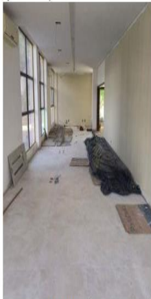
Piso 2: piso e forro.
