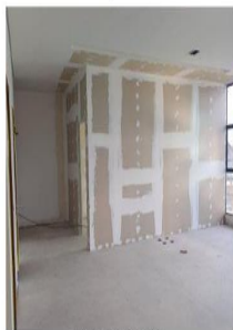
Drywall sala servidor
