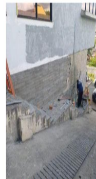
Vista lateral fachada externa com ripado concreto.
