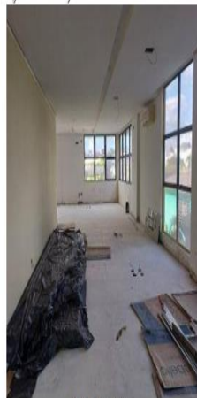
Piso 2: piso e forro.
