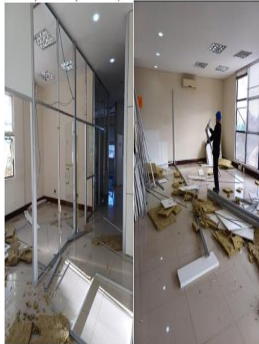
Retirada das divisórias do terceiro pavimento
