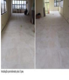
Instalação porcelanato piso 3 pav.
