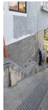
Visão lateral fachada externa com ripado concreto.
