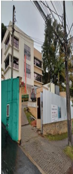
fachada com duto de calça e tapume externo
