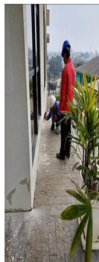
Tratamento de infiltrações
