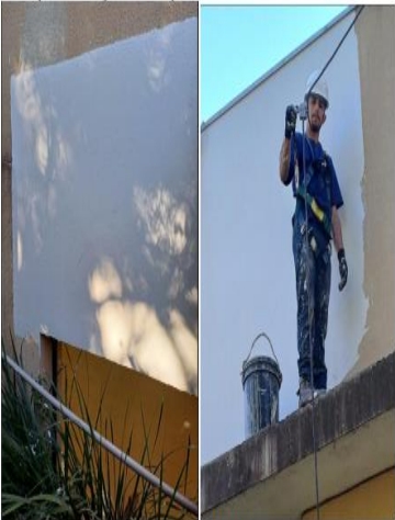
Teste com massa niveladora
