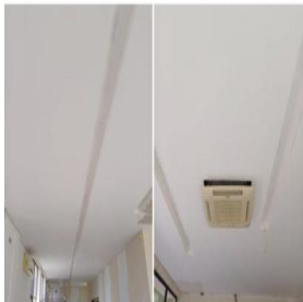
Trabalho no fôrmo para instalação de iluminação
