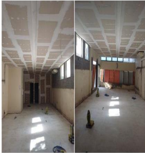
Recepção: Piso, forro e ripado concreto concluídos.
