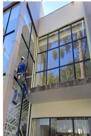
Limpeza da fachada
