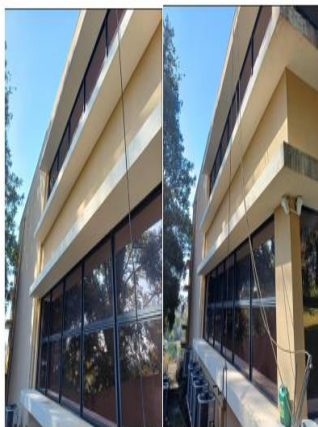
Limpeza da fachada e abas em laje
