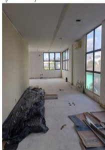
Piso 2: piso e forro.
