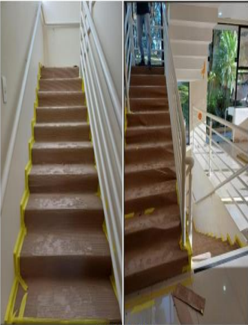
Proteção das escadas
