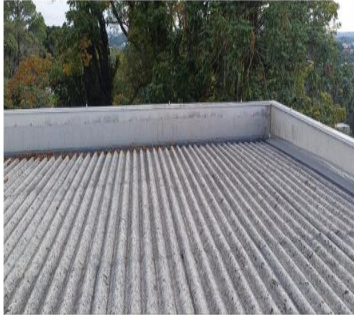
Ancoragem na cobertura
