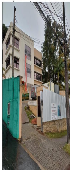
fachada com duto de calça e tapume externo
