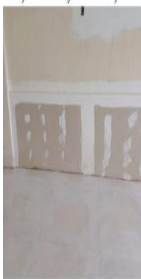
Preenchimento com drywall na parede
