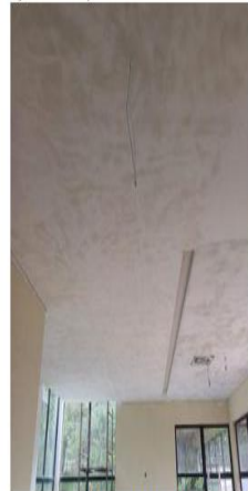
Cimento forro área gourmet
