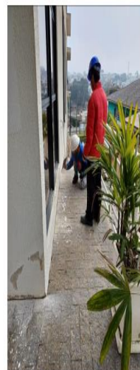
Tratamento de infiltrações
