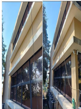
Limpeza da fachada e abas em laje
