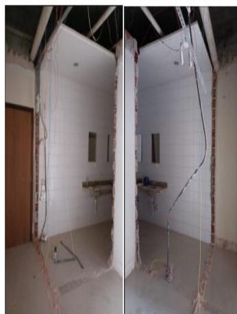
demolição parcial do banheiro feminino e masculino do 1 pavimento
