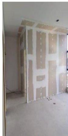
Drywall sala servidor
