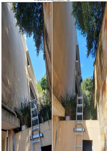
Limpeza da fachada
