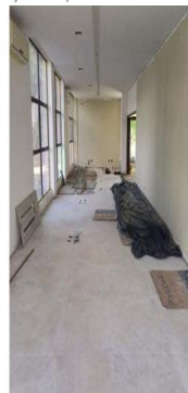
Piso 2: piso e forro.
