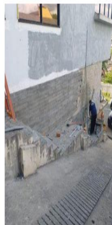
Vista lateral fachada externa com ripado concreto.
