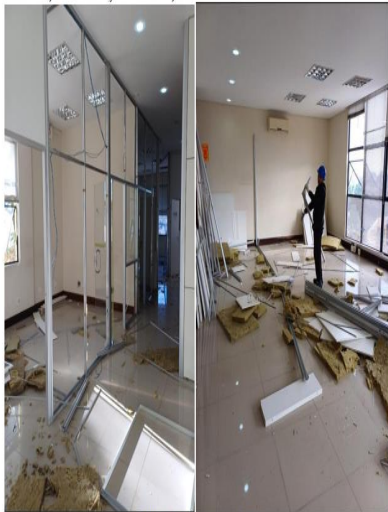
Retirada das divisórias do terceiro pavimento
