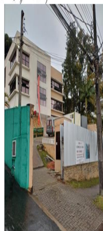
fachada com duto de calça e tapume externo
