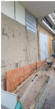
Fachada: floreira em alvenaria
