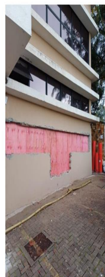
abertura de vão para nova recepção
