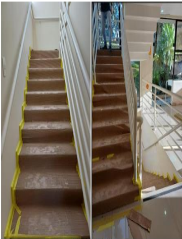
Proteção das escadas
