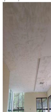
Cimento forro área gourmet
