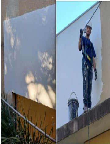
Teste com massa niveladora
