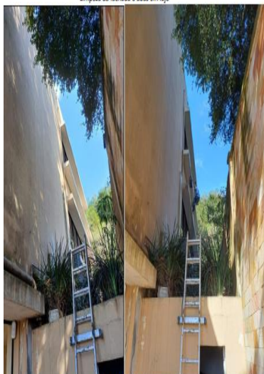
Limpeza da fachada
