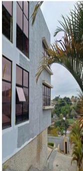
Aplicação parcial do cimento queimado
