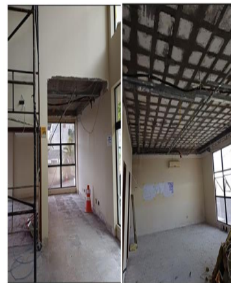
demolição do segundo pavimento: gesso, drywall e porcelanato
