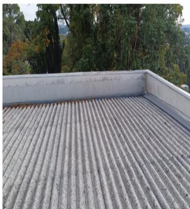
Ancoragem na cobertura
