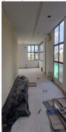
Piso 2: piso e forro.
