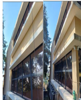
Limpeza da fachada e abas em laje
