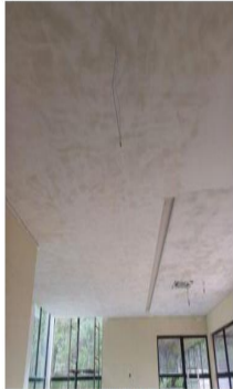
Cimento forro área gourmet
