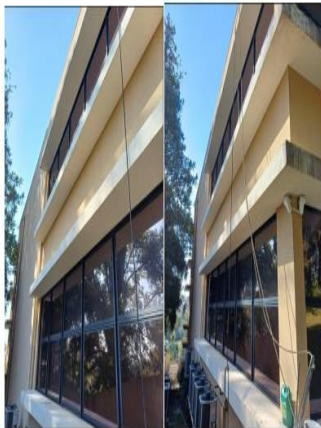
Limpeza da fachada e abas em laje
