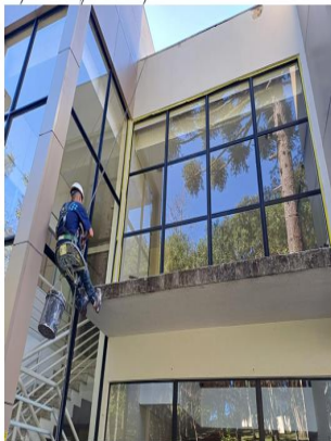
Limpeza da fachada
