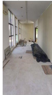
Piso 2: piso e forro.
