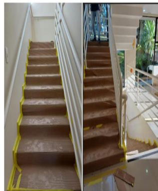
Proteção das escadas
