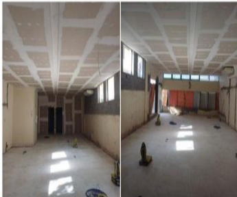
Recepção: Piso, forro e ripado concreto concluídos.
