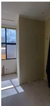
Sala apoio auditório concluída.
