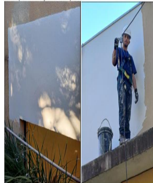
Teste com massa niveladora
