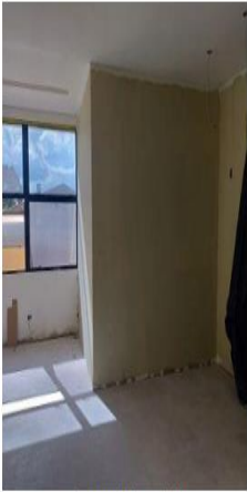
Sala apoio auditório concluída.
